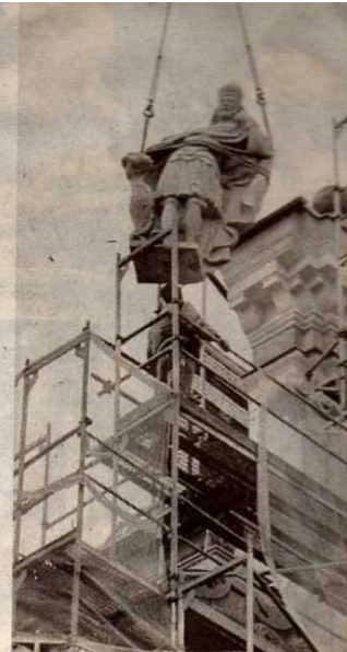
Näher, mein Gott, zu Dir: Der „neue“ Heinrich der Heilige schwebt auf seine Platz in der Fassade der Karmelitenkirche
